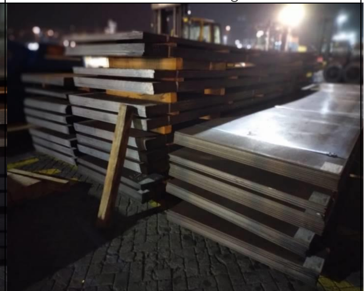
20. Vista del avance de la descarga y planchas en acopio.
