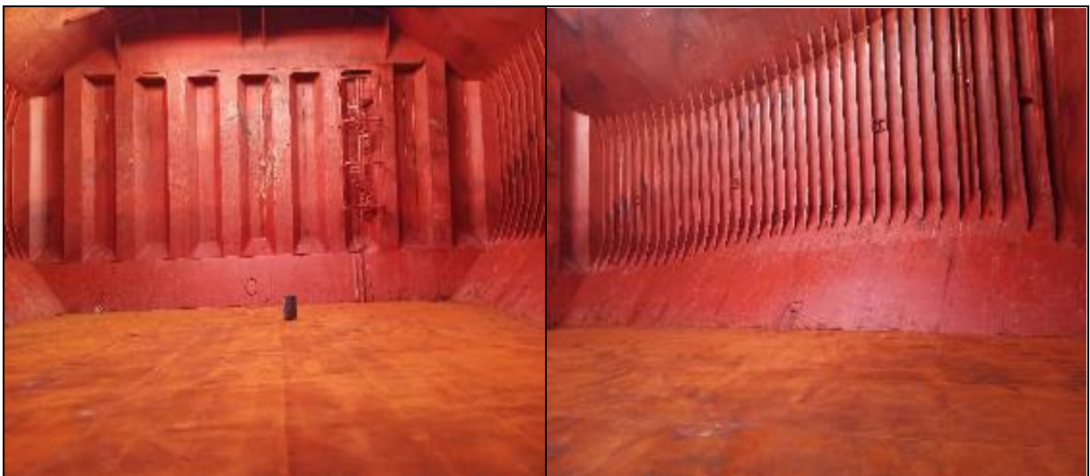
3. Mamparo de popa sin restos de carga.
