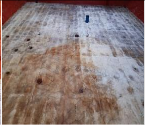
6. Piso de la bodega apto para encalar.
