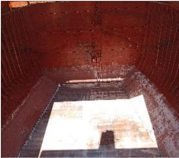
13. Proa de la bodega N° 1, recubierta con cal.
