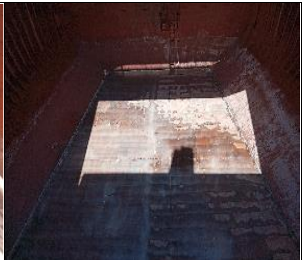
16. Fondo de bodega debidamente recubierta con cal.
