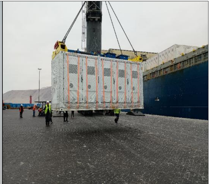
36. BESS siendo posicionado en el delantal del muelle.
