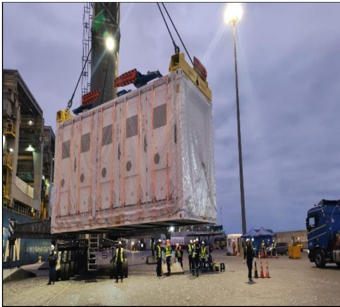
15. Proceso de descarga.
