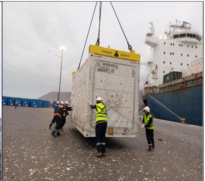
8. Batería siendo posicionada en delantal del muelle.
