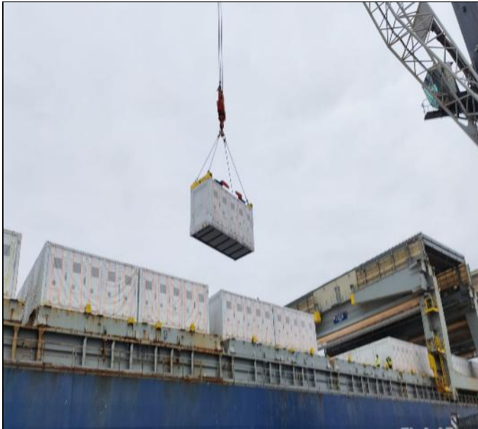
5. Inicio de las operaciones de descarga de los BESS.
