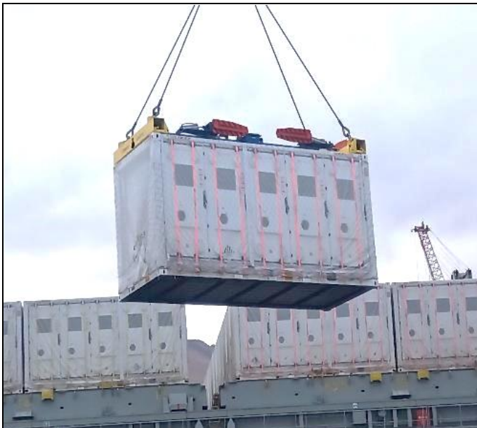
7. BESS siendo descargados desde la cubierta principal.
