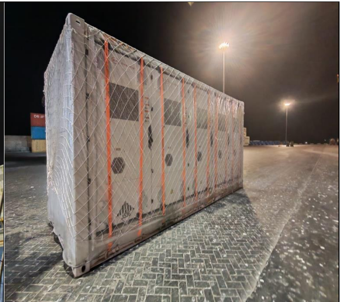
22. Baterías posicionadas en el delantal del muelle.
