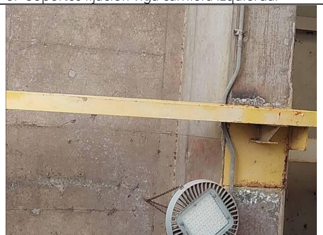
10.- Vista inferior de viga carrilera izquierda.
