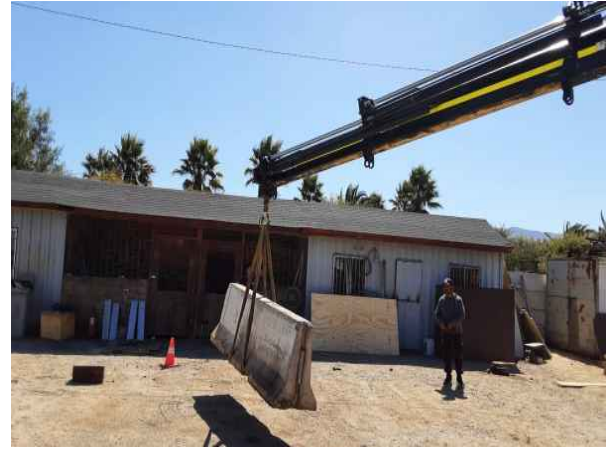
6.- Inicio prueba de carga.
