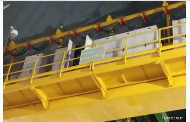
2.- Gancho auxiliar puente grúa n° 2.
