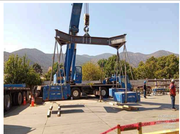
4.- Prueba de carga en ejecución.
