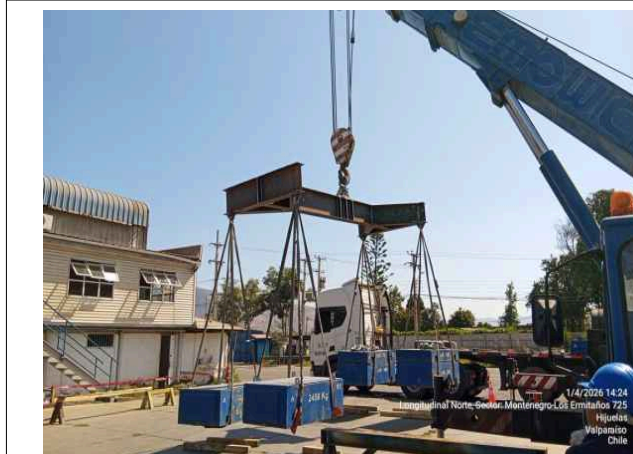
3.- Prueba de carga en ejecución.
