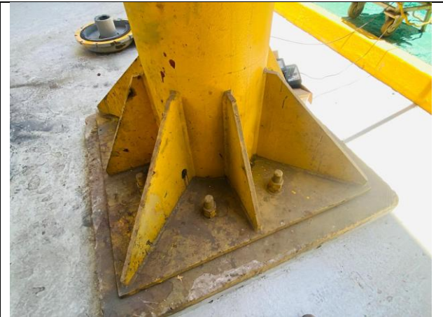
2.- Base del jib crane en buen estado.
