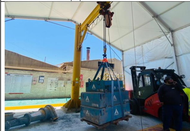
9.- Prueba de carga en proceso.
