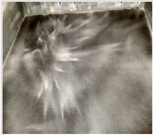
36. Fondo de la bodega recubierta con cal.
