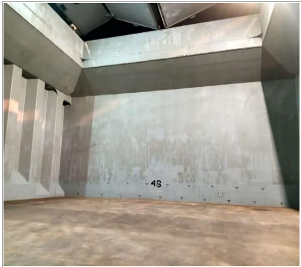
14. Banda de estribor en condiciones de encalar.
