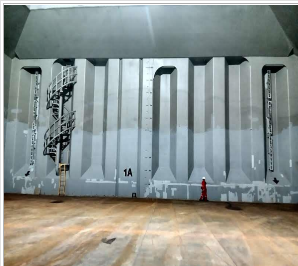
3. Mamparo de popa sin restos de carga.
