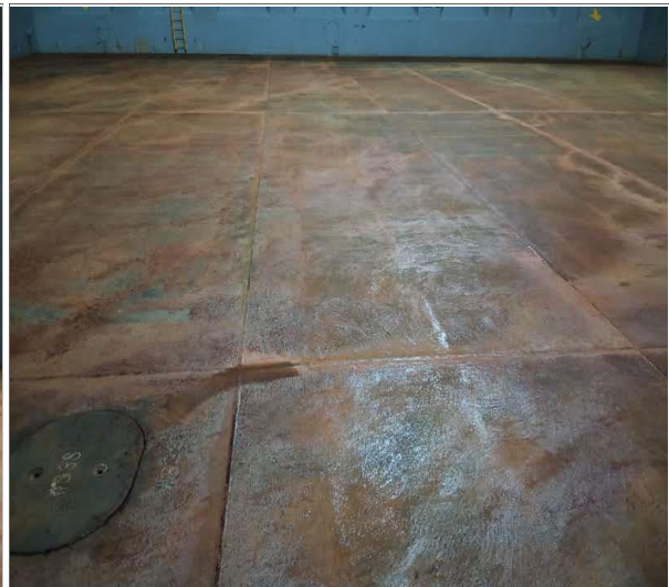
10. Piso de la bodega apto para encalar.
