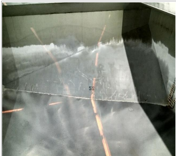
38. Vista banda de estribor.
