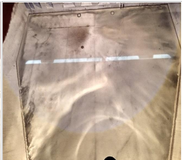
20. Fondo de bodega debidamente recubierta con cal.
