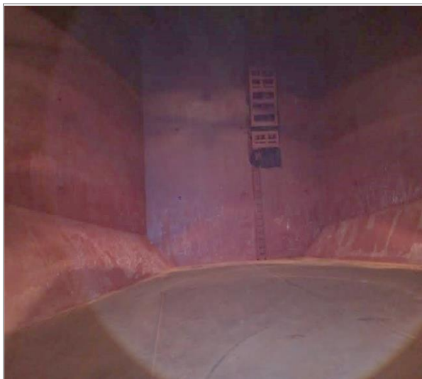
1. Vista de la proa bodega N° 1.
