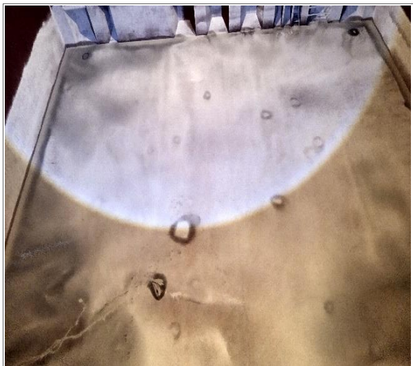
28. Fondo de la bodega recubierta con cal.
