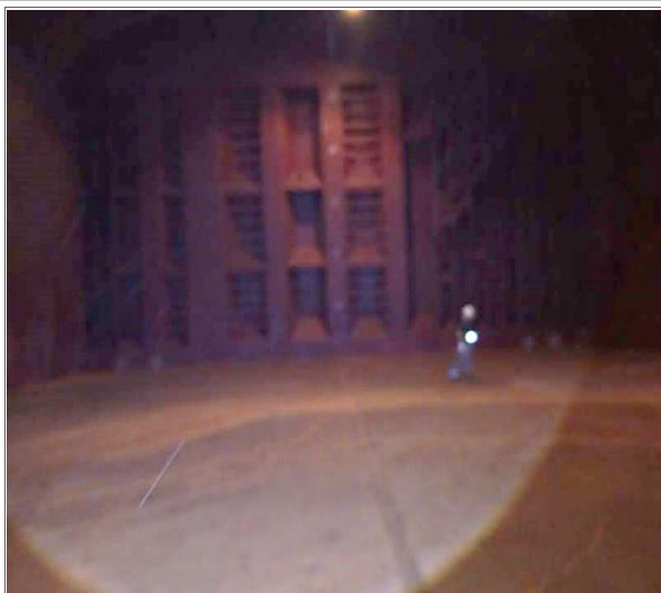
3. Mamparo de popa sin restos de carga.
