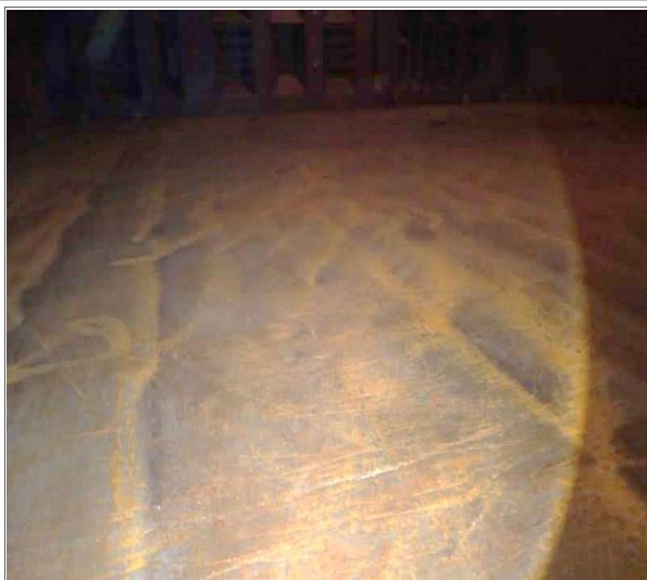
7. Piso al interior de la bodega.
