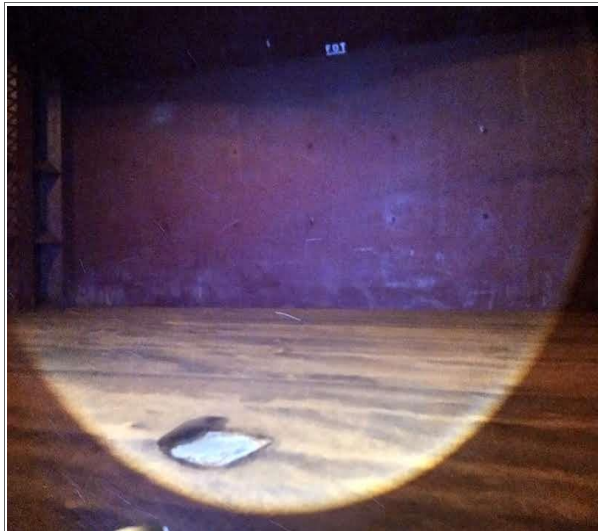
10. Banda de estribor en condiciones de encalar.
