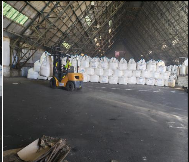
6. Carga siendo trasladada desde el sector de acopio.
