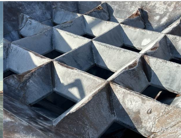
10. Vigas en orden.
