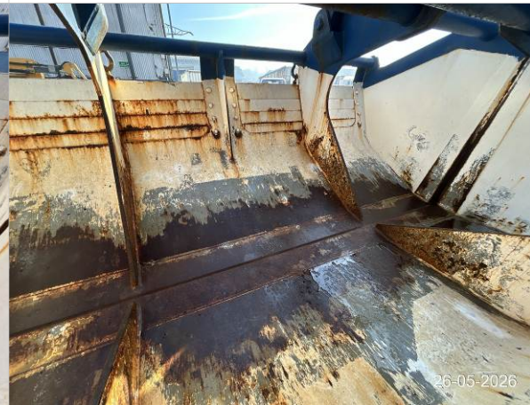
16. Otra vista del interior en condiciones.
