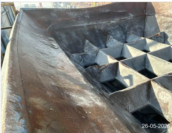
11. Planchas sin óxido suelto.
