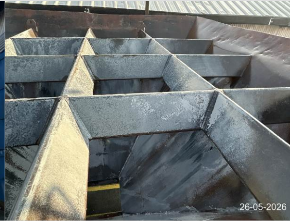
2. Vigas en condiciones de operar
