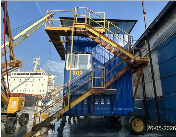
1. Vista general del buzón de transferencia N° 101.
