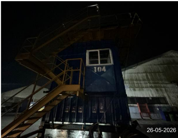
5. Vista general del buzón de transferencia N° 104.
