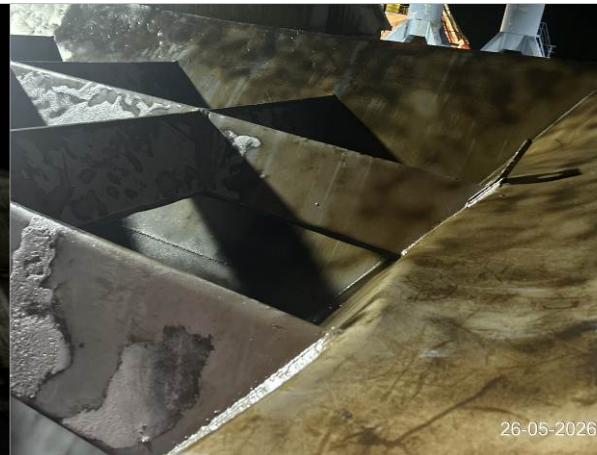
6. Planchas limpias, en buenas condiciones.
