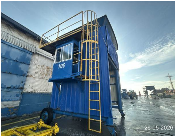
9. Vista general del buzón de transferencia N° 105.
