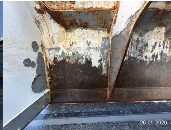
18. Interior en buenas condiciones.
