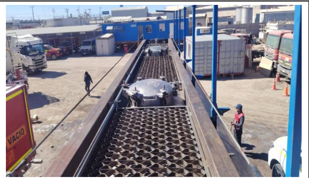
2.- Otra vista (fuga, general, ductos, tapa).
