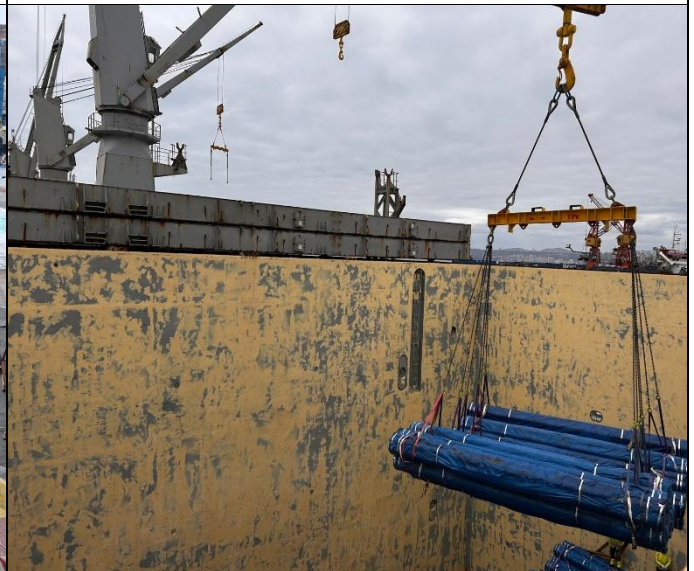
28. Descarga de paquetería de tubos desde H5.
