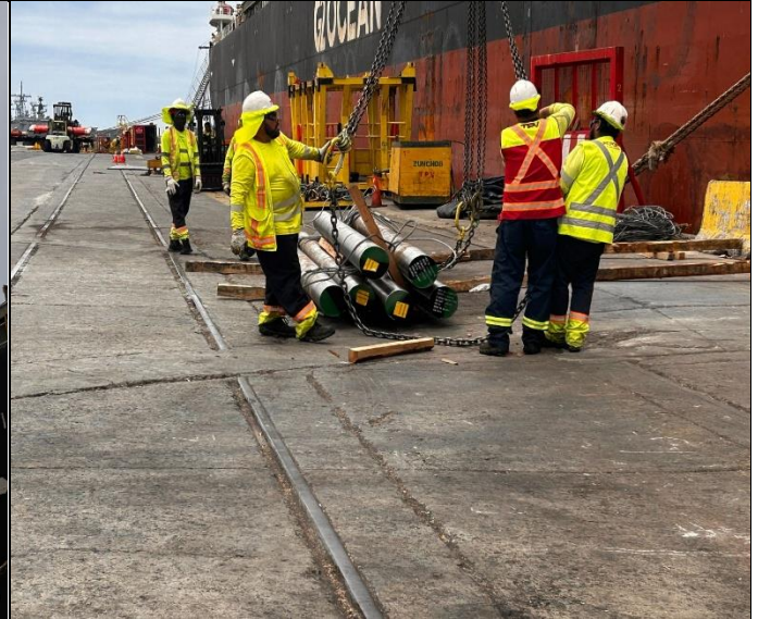
40. Descarga de barras de acero macizas a un costado de la nave.
