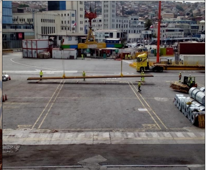
12. Acopio inicial de los primeros rieles descargados.
