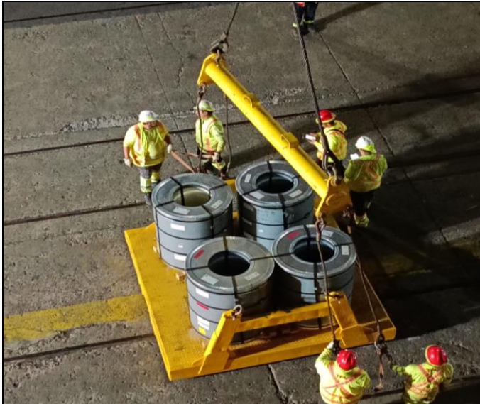
37. Bobinas paletizadas posicionadas en muelle y estibadores soltando maniobra.
