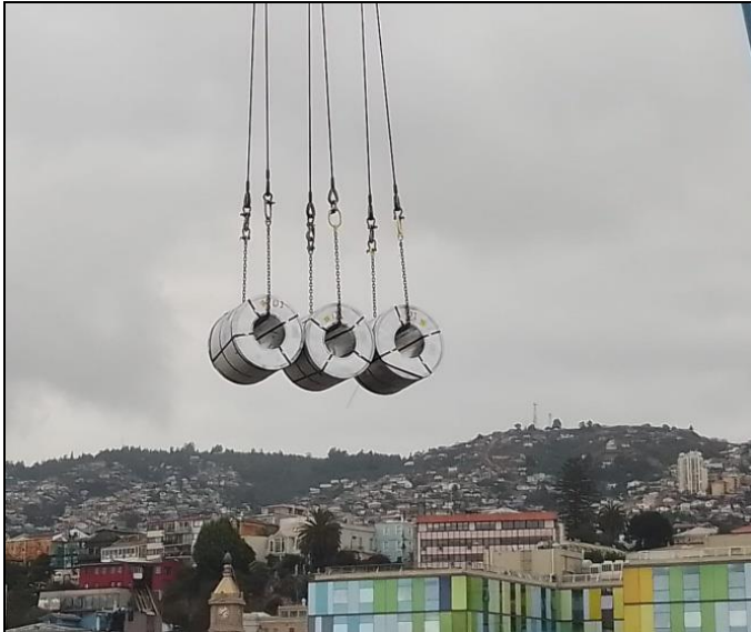
45. Bobinas galvanizadas siendo descargadas desde H2.
