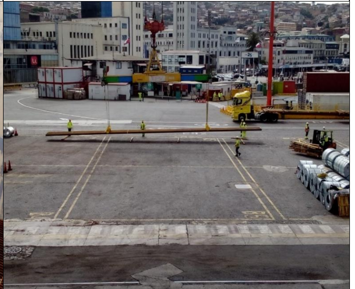
12. Acopio inicial de los primeros rieles descargados.
