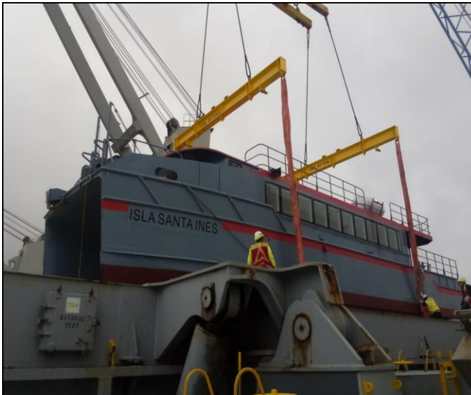
17. Instalación de maniobras de izaje, para la descarga de Passenger boat.
