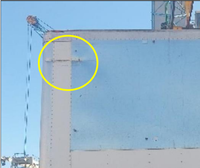
33. Panel frontal con abolladura en la zona superior.
