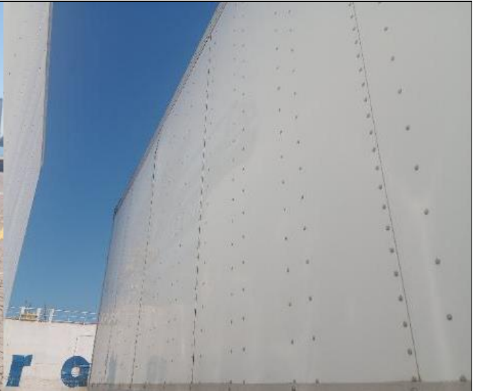
82. Panel lateral derecho abollado.
