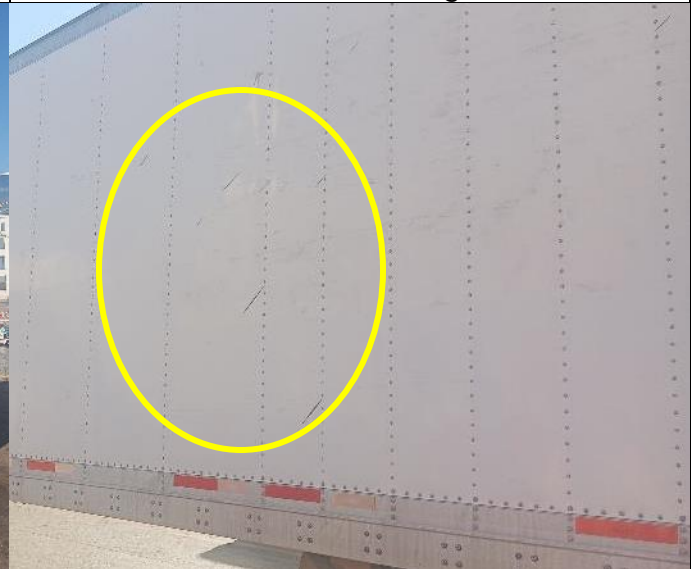
16. Pintura rayada en varios sectores del panel lateral izquierdo.
