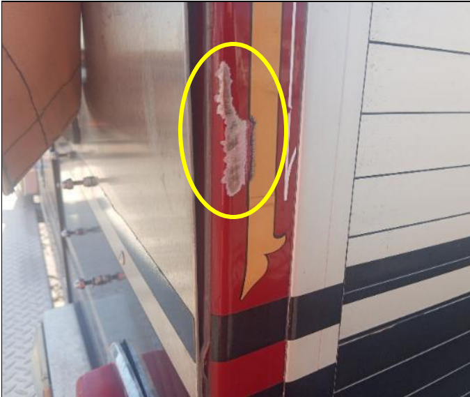
65. Pintura de la puerta izquierda trasera rayada, daño ocasionado por los estibadores.
