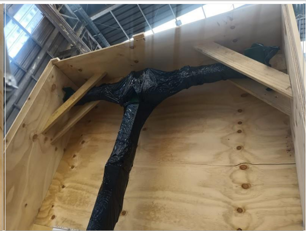
102. Vista de la madera dispuesta para evitar desplazamientos.
