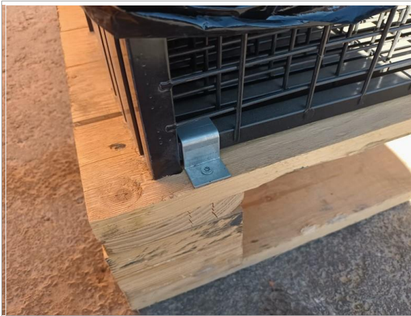
141. Vista de la sujeción en la base.
