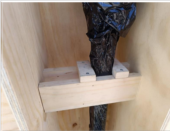
65. Vista de la madera dispuesta para evitar el desplazamiento.
