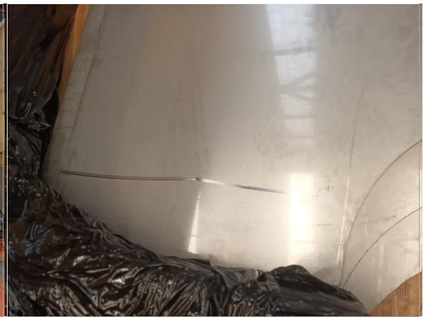
42. Vista de la raspadura superficial.
