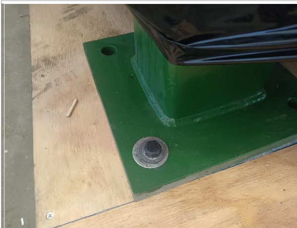
15. Vista de la sujeción en la base de la carga.
