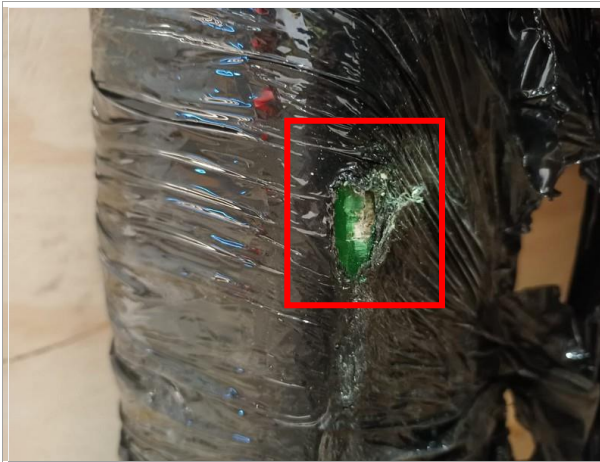
53. Vista de la raspadura en la pintura.
