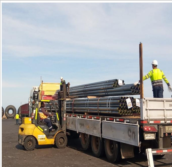
29. Tuberías siendo posicionadas sobre camión.
