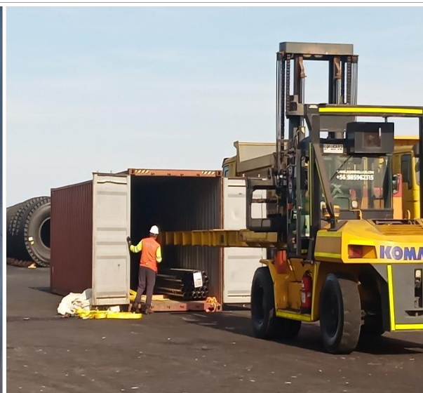
22. Tuberías siendo posicionadas para ser desconsolidadas.
