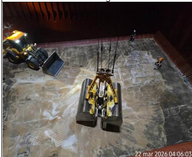
53. Operaciones de barrido al interior de la bodega 4.
