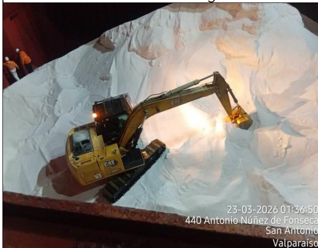
35. Retroexcavadora acopiando sal limpia al interior de bodega #3.
