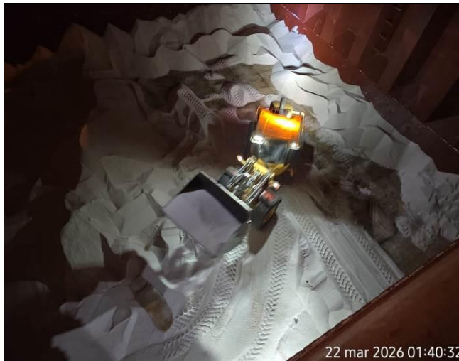
41. Cargador frontal acopiando sal limpia al interior de bodega #4.
