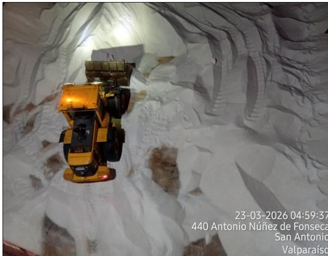
37. Cargador frontal acopiando sal limpia al interior de bodega #3.
