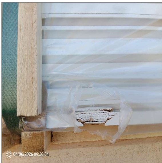
73.- Vista a daño de 2 piezas en lote 3623206047.
