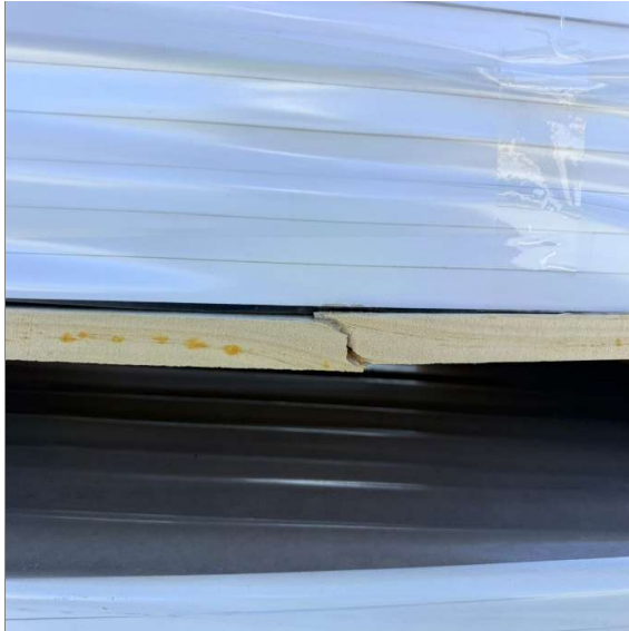
113.- Vista a tabla basal quebrada en lote 3623220284.
