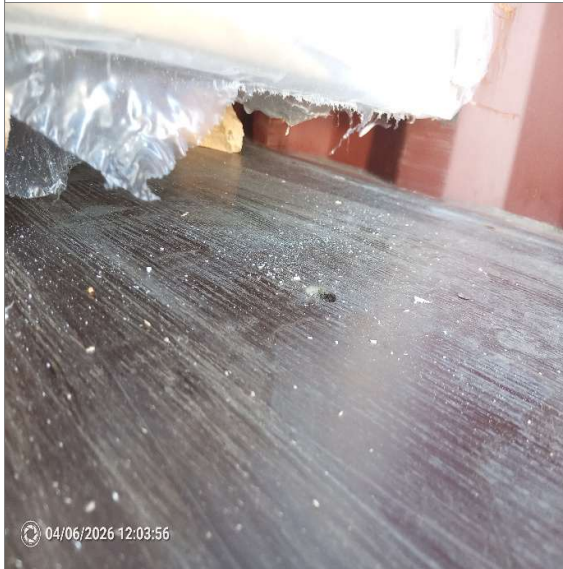
103.- Vista daño en trineo y parrilla durante consolidado en lote 3623219938.
