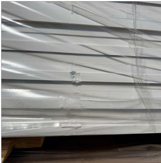
109.- Vista a daño en 1 pieza en lote 3623220098.
