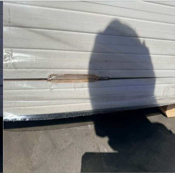
94.- Vista a misma pieza con otro daño en lote 3623220056.
