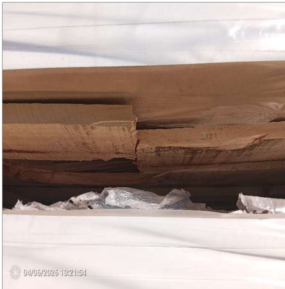
81.- Vista a tabla de parrilla quebrada en lote 3623219716.
