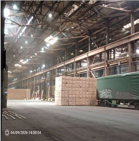
17.- Vista zonas de acopio en 204.
