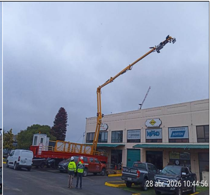
10.- Vista de Grúa en ángulo de trabajo.
