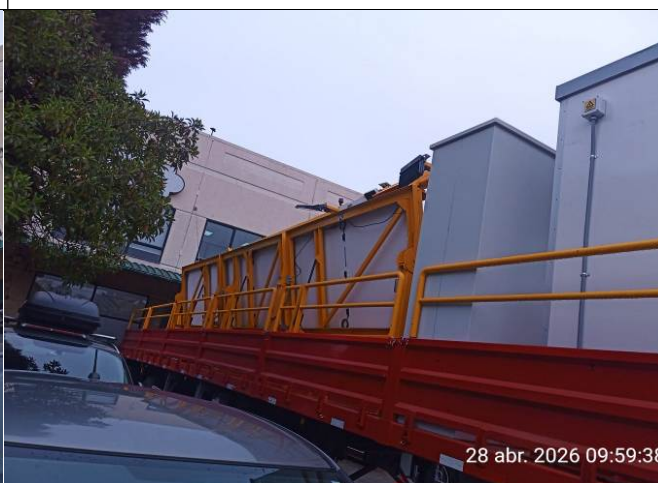
8.- Vista de baranda anticaídas sector paneles solares D-E y F en rampla soporte de Grúa.
