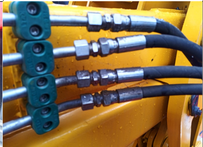
16.-Vista de terminales de hidráulicos sin signos de fuga.
