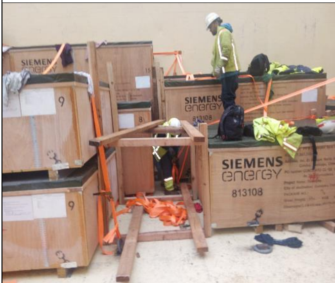
23. Cajonería con choqueo de madera y trincadas con fajas sintéticas. No se observa carga desplazada.
