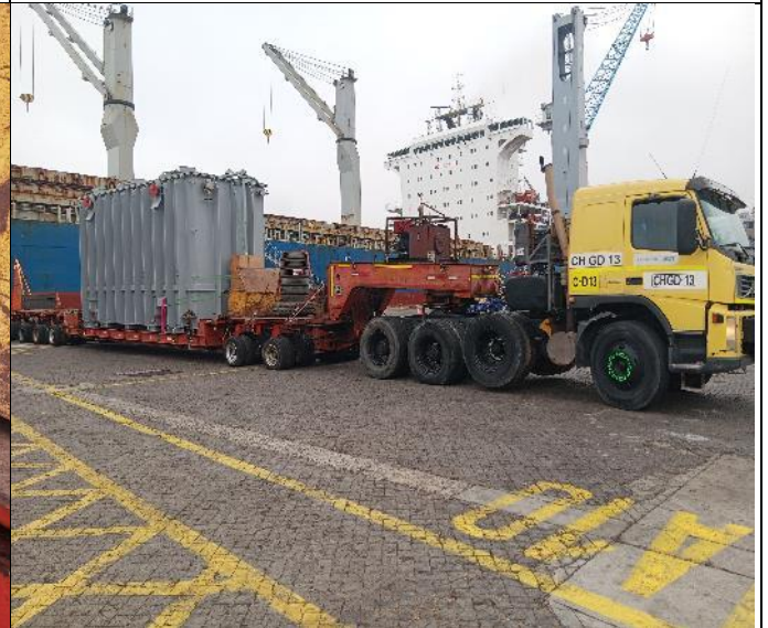
48. Camión trasladando transformador hacia el patio bellavista.
