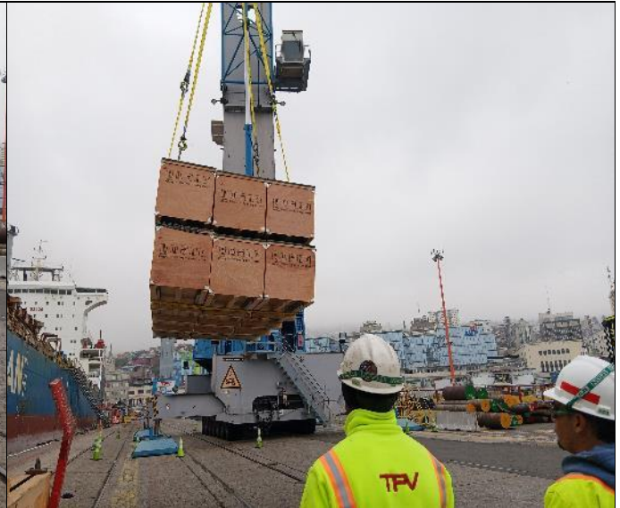
54. Operaciones de descarga de cajones de madera desde bodega No. 5
