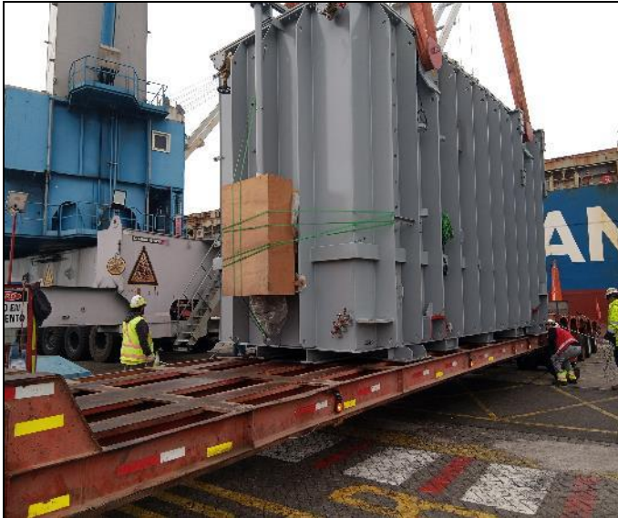
37. Otra vista de transformador posicionado sobre camión.
