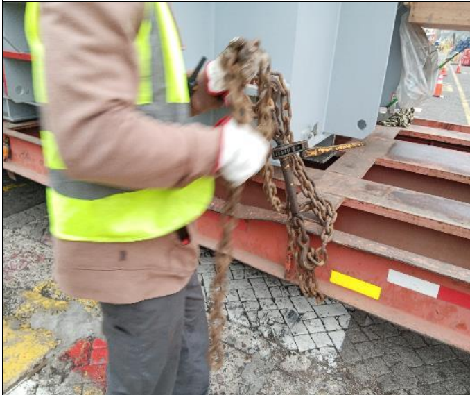
39. Transformador en proceso de trincado.
