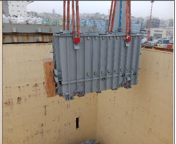
34. Transformador No.1 en proceso de descarga.
