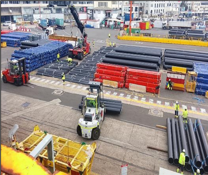
61. Grúa horquilla transfiriendo tuberías a la zona de acopio.
