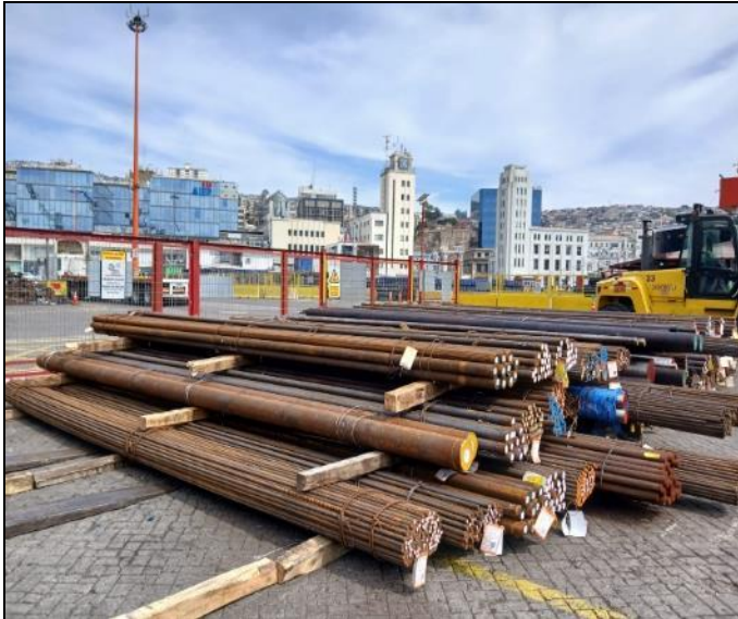
21. Avance de macizos acopiados en muelle.
