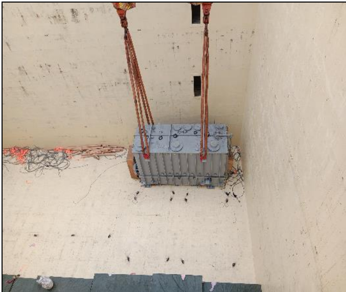
41. Transformador No. 2 en proceso de descarga.
