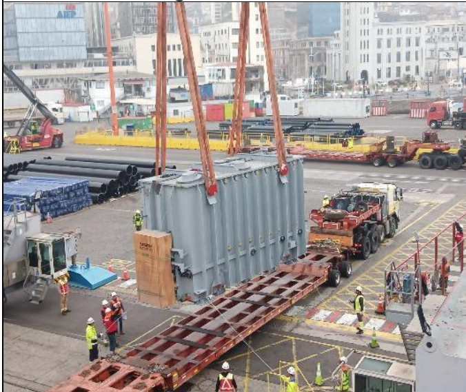
35. Transformador No. 1 siendo cargado directamente sobre camión.
