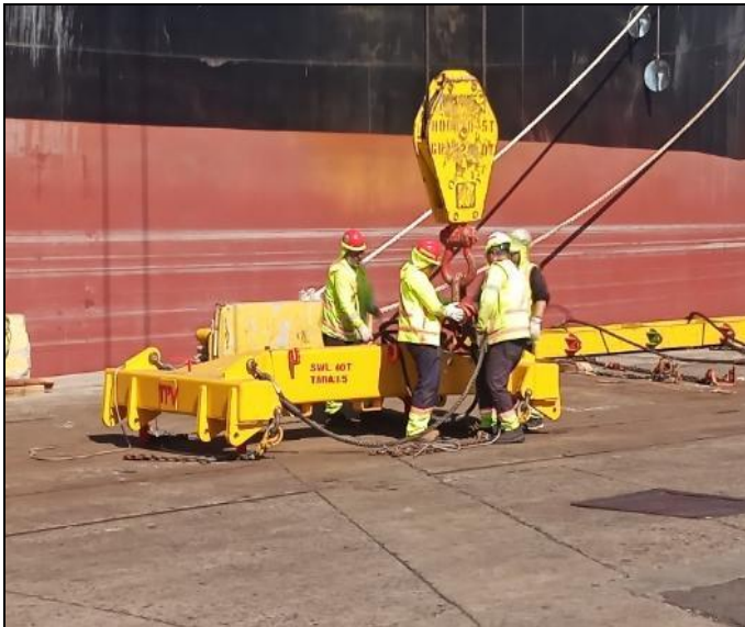
9. Maniobras utilizadas para las diferentes descargas.
