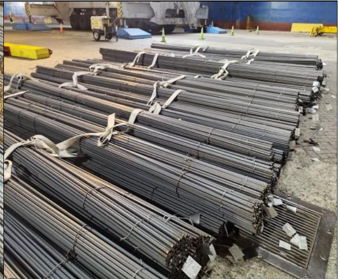
74. Vista de la zona de acopio en el muelle.
