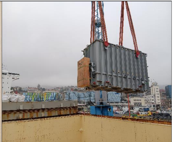
42. Transformador No. 2 siendo descargado.
