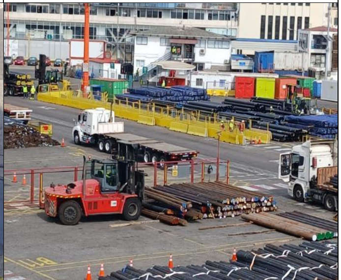
20. Macizos de acero siendo trasladados a la zona acopiados por la grúa horquilla.
