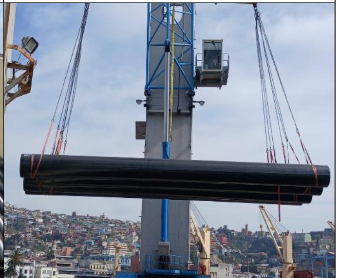
60. Tubos en operaciones de descarga.
