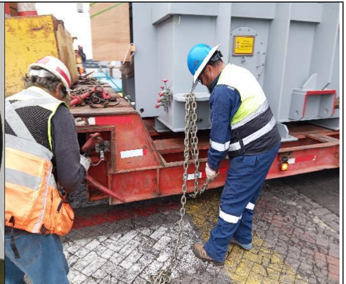
46. Transformador en proceso de trincado con cadenas.
