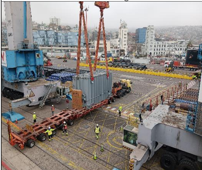
43. Transformador No. 2 siendo cargado directamente sobre camión.
