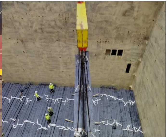
10. Inicia la descarga de atados de alambrones de acero.
