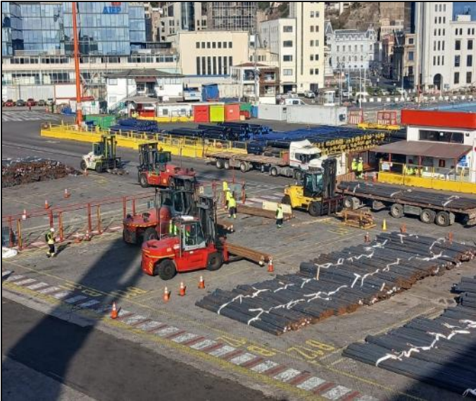
17. Grúa horquilla trasladando macizos de acero hacia el sector de acopio sitio No. 8.
