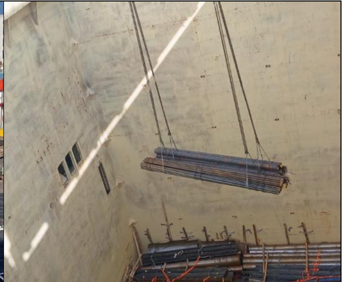
18. Macizos de acero en proceso de descarga desde bodega No. 3
